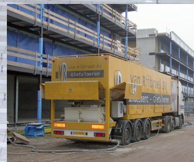
Productie van gietspecie op de bouwplaats.
