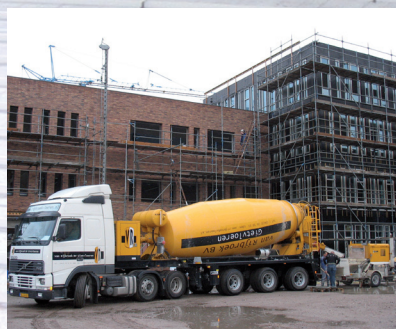
Aanvoer van kant en klare gietspecie vanaf onze centrale naar de bouwplaats.
