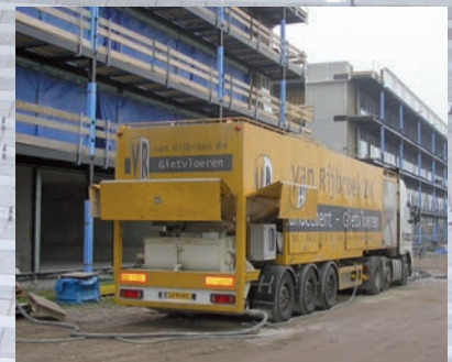
Productie van gietspecie op de bouwplaats.
